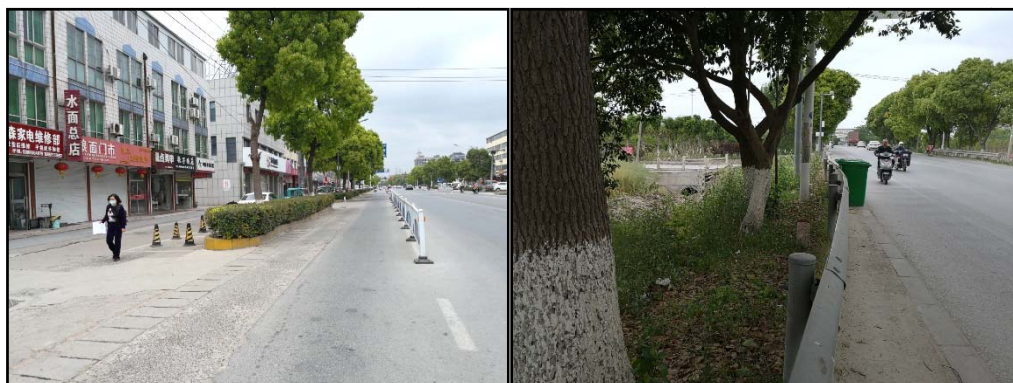
图 2.3-3 现状路基防护状况
